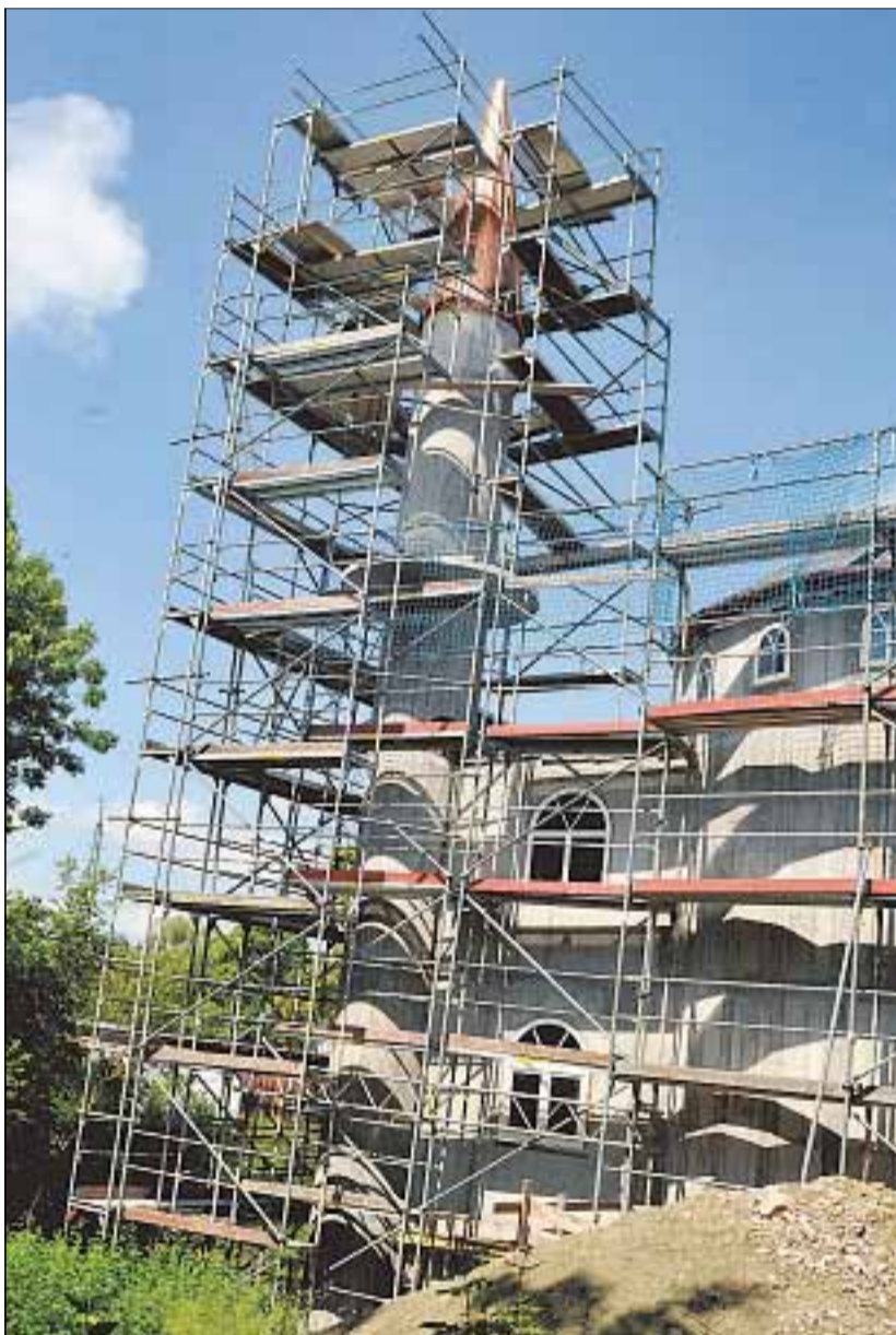
Seit kurzem ist das Minarett der Villingener Moschee mit Kupferblech verkleidet. Die Kuppel soll nun bald folgen. Foto: Jochen Hahne
